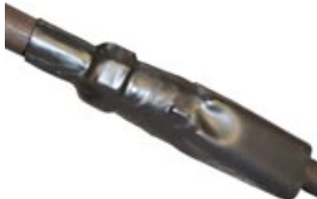
2 Von einem Ende oder von der Mitte ausgehend Schrumpfschlauch bzw. -muffe aufschumpfen.
